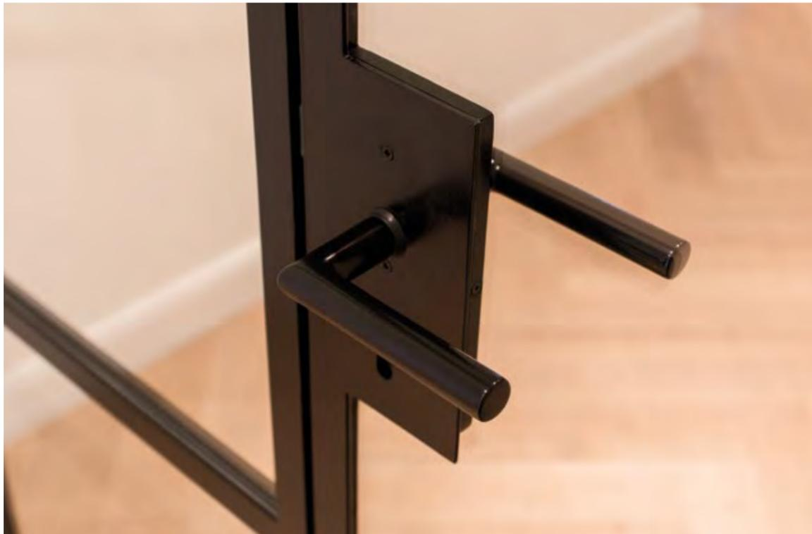
**Stahlgriff:** Stimmig zum Gesamtkonzept der Türelemente wurden Schlosskasten und Drückergarnitur ebenfalls aus Stahl gefertigt
